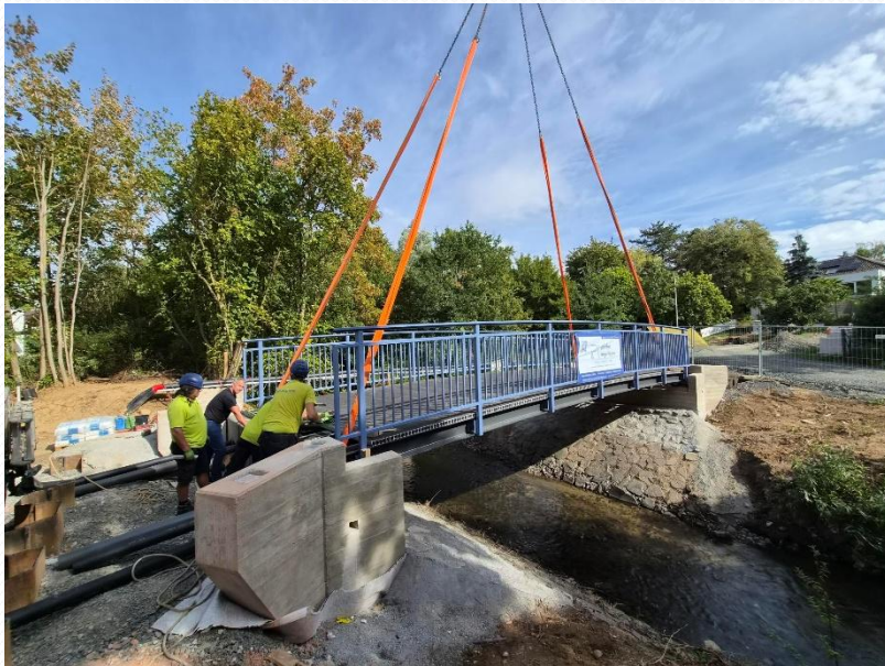
Geh- und Radweg inkl. Brückenneubau „Unterer Steg“ in Massenheim
