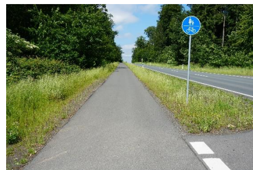
Radweg an der Kreisstraße 246 Richtung Groß-Karben
