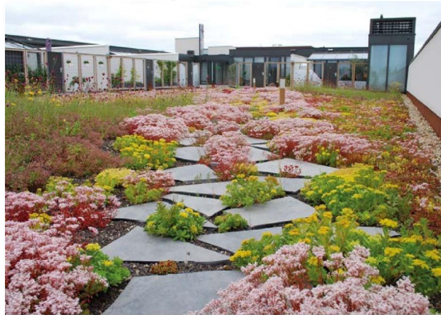
Abb. 10: Von einfacher Begrünung bis üppigem Dachgarten: Alles möglich! © Optigrün International AG
