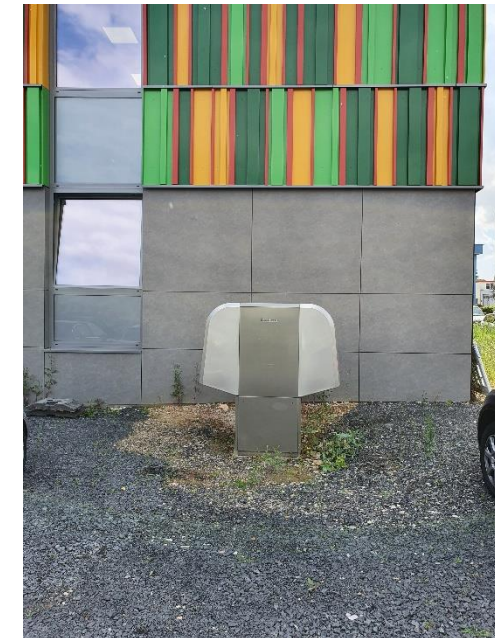
Verwaltungsgebäude Homburger Straße 17
